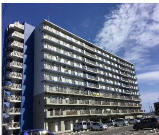
気仙沼市南郷災害公営住宅（2016 年 10 月）
