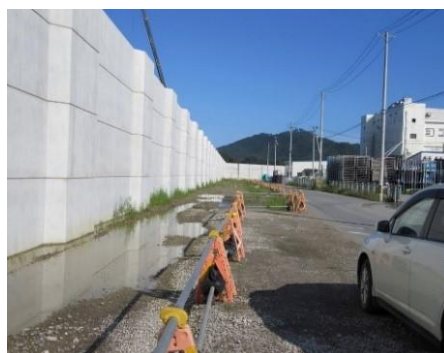
海を遮るコンクリート防潮堤 (2016 年、気仙沼市)
